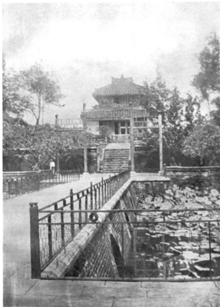
Planche IV. — Au Tombeau de Thiệu-Trị : le pavillon Đức-Hình, vu par derrière ( Cliché Mlle Géhin ).
